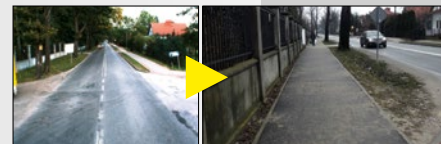
12 Chodnik przy drodze Nr 2713W - Celestynów
